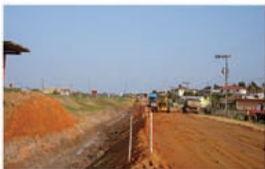
Terraplanagem da Rodovia Mercosul, SC
