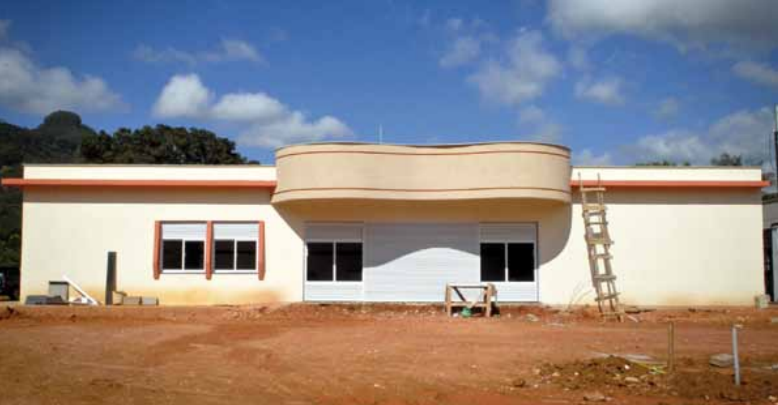
Construção do Centro de Referência da Assistência Social - CRAS no Bairro Vila da Mata - Sede do Município
