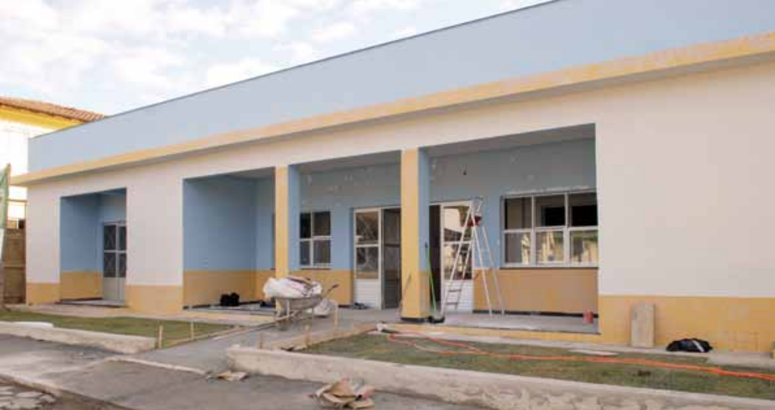
Construção da creche no Bairro Vila Betânea
