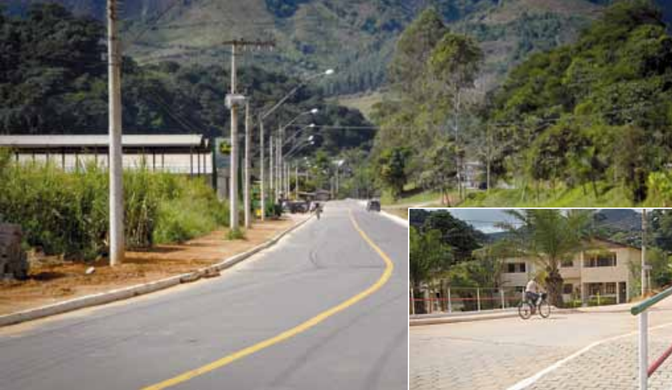
Drenagem, pavimentação e construção de ponte de concreto na Avenida Tapera
