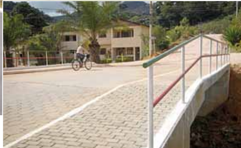
Construção da ponte de concreto no Bairro Minete
