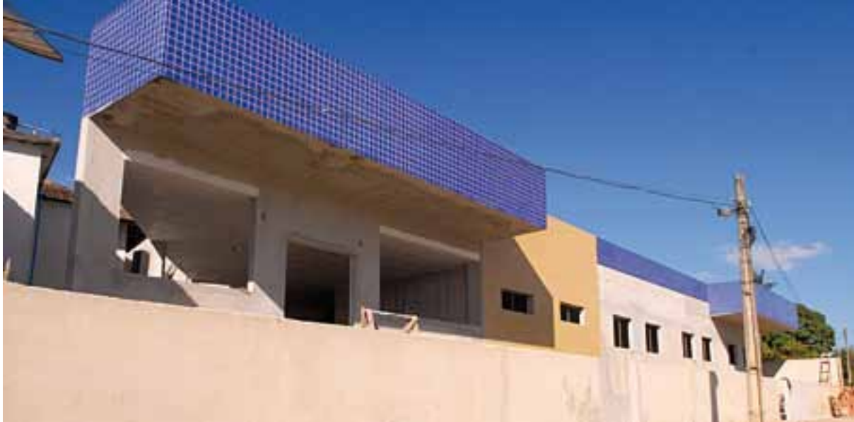
Ampliação da Escola Municipal de Alto Caxixe
