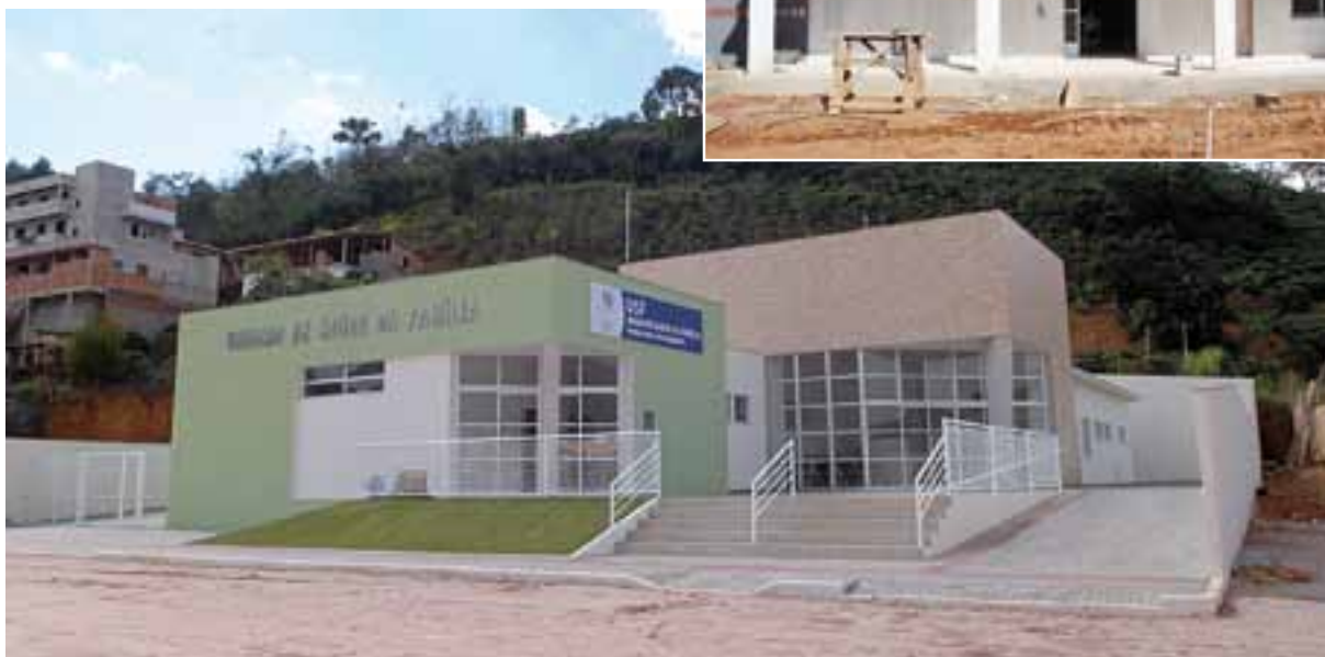
Construção da Unidade Saúde da Família, Bairro Minete - Sede do Município
