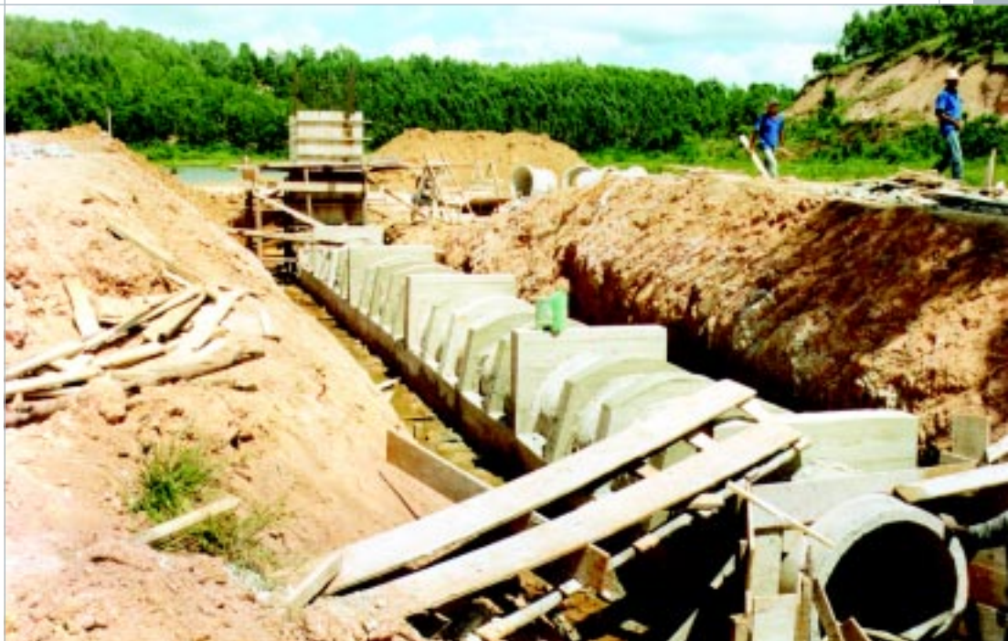
Construção do monge da Barragem de Jundiá
