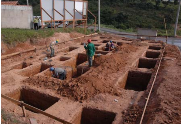
Construção de casas na Vila Esperança
