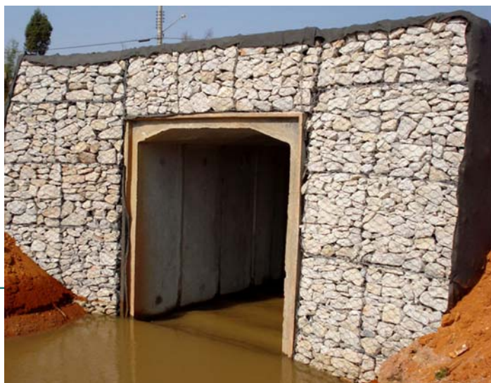
Obra de alteamento do córrego Pinheirinho
