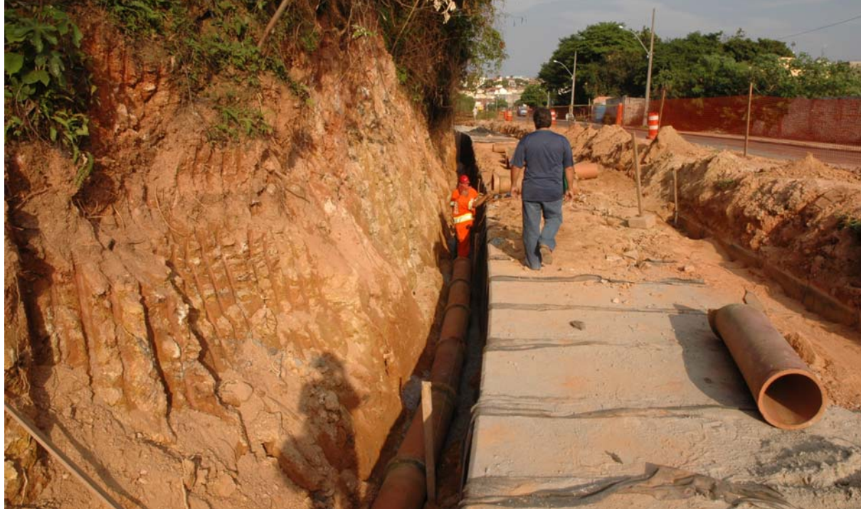
Obras no córrego Colônia
