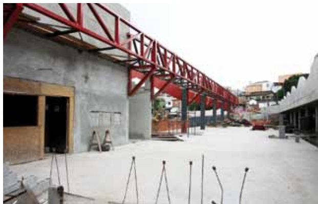
Construção do Centro de Educação Unificada (CEU) do Jardim Elvira
