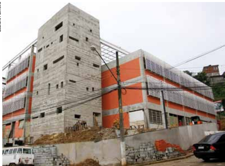
Construção da Creche e Escola Municipal de Educação Infantil do Jardim São Pedro
