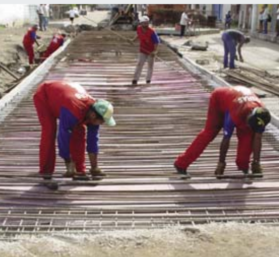
Obra de macrodrenagem na rua Felicidade Siqueira
