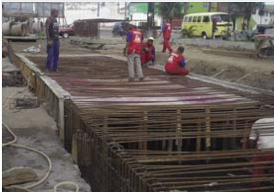
Obras de macrodrenagem na rua Felicidade Siqueira - Bairro Alvorada
