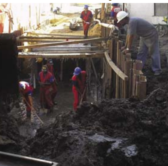
Obras de macrodrenagem - Bacia Aribiri
