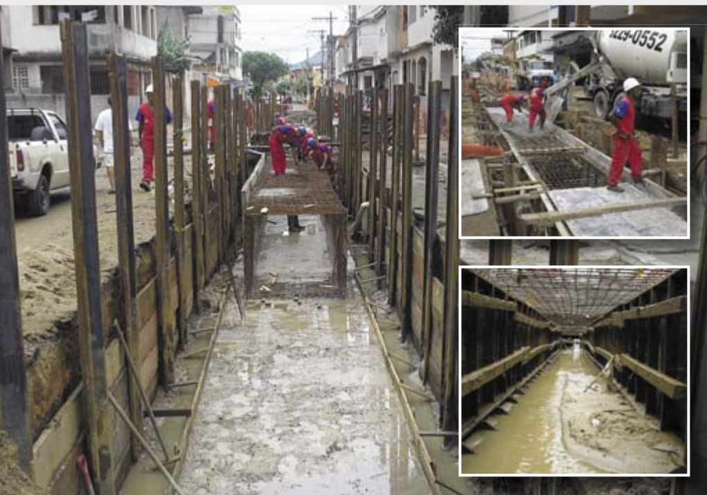
Obras de macrodrenagem na Rua Vital Brasil - Bairro Soteco
